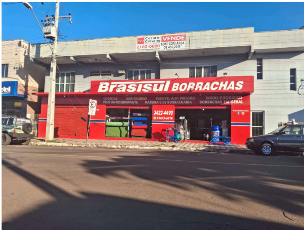
Figura 2: Fachada da frente do imóvel para a Avenida Rio de Janeiro.
