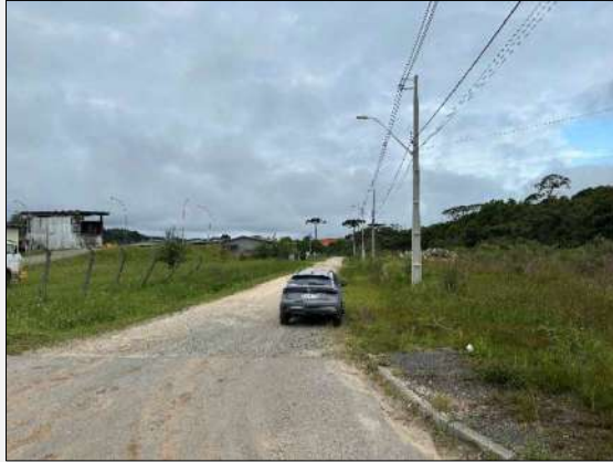
Foto 1 – Logradouro do imóvel
